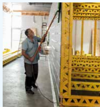
Fig. 1 Bouw van het buitenste scherm in elektrische staal (juni 2024).
